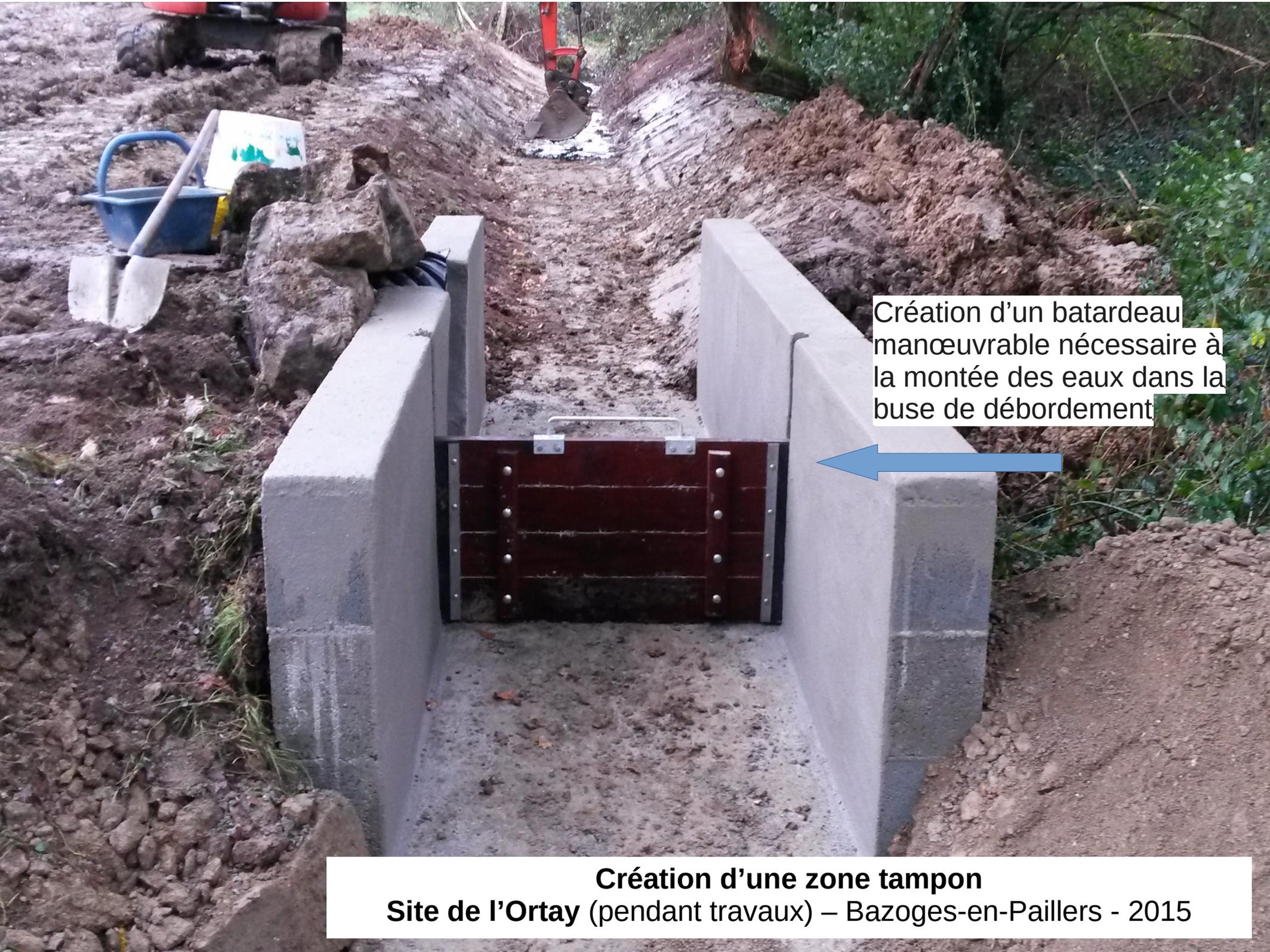
Création d'un batardeau manœuvrable nécessaire à la montée des eaux dans la buse de débordement
